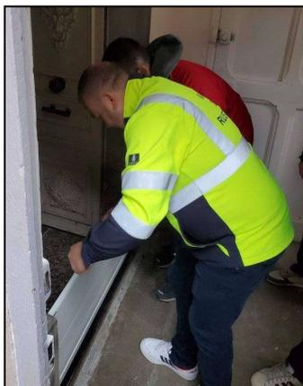
Simple et rapide, la pose de batardeau est un outil essentiel de la protection des bâtiments face au risque inondation.
